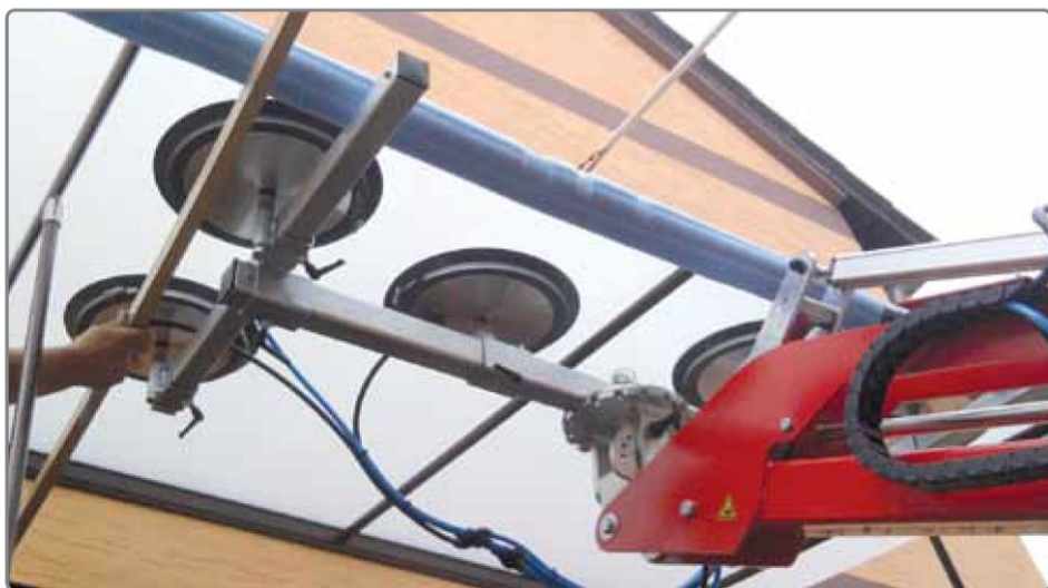
Fej feletti üvegező modullal rendelkezik a szükséges szerelési rugalmassághoz.
