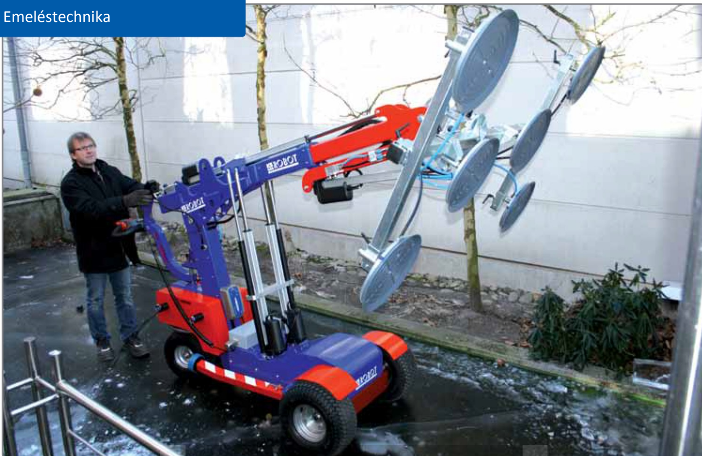
KS Robot 600 Offroad túréspróba - még jégen is jól teljesít. Egy befagyott tó az egyetlen lehetséges hozzáférési útvonal a tetőüvegezés elvégzéséhez.
